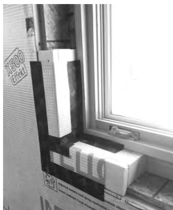
图7 外窗与窗洞口连接处粘贴气密性胶带
