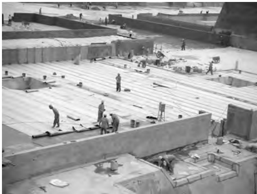
奥运村地下底板施工现场
