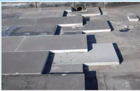
XZD 无机改性聚氨酯保温板应用在被动式绿建体验中心屋顶上
