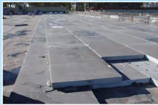
XZD 无机改性聚氨酯保温板应用在被动式绿建体验中心屋顶上
