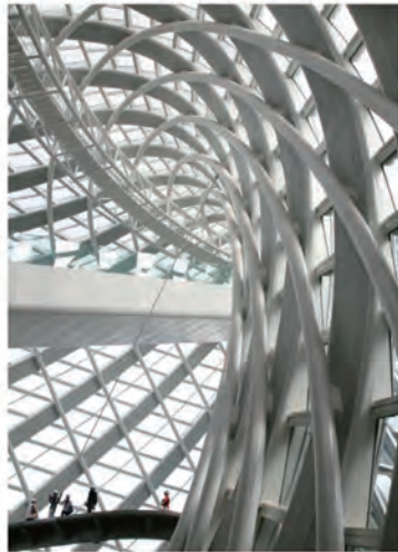
双向叠合网格结构体系东中庭内景
