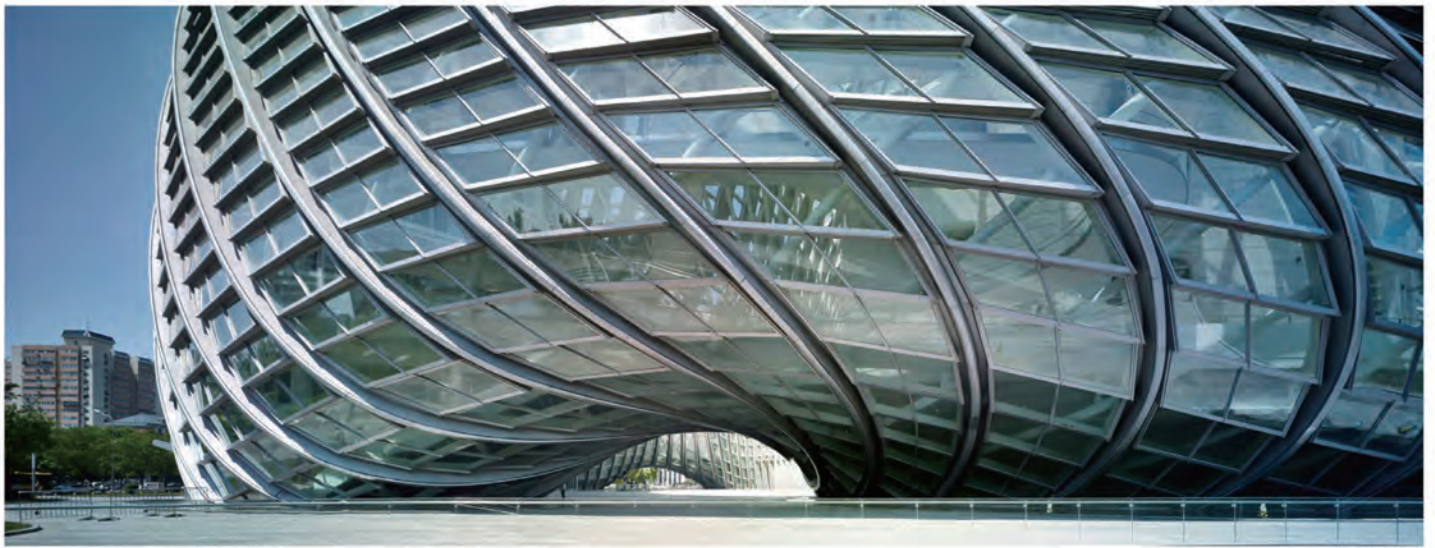
东侧幕墙实景
