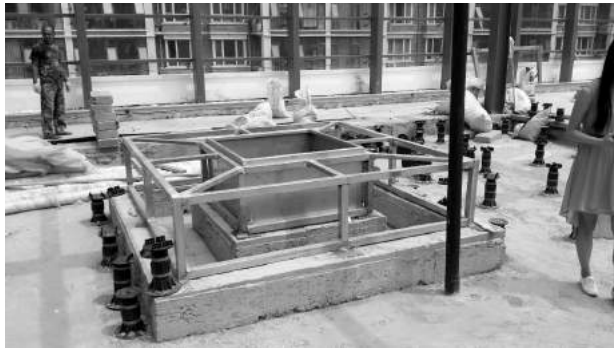
图 15：轻体砖结构树池座凳做法照片
