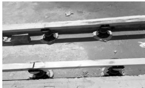
图12：万能支撑器做法（木园路）
