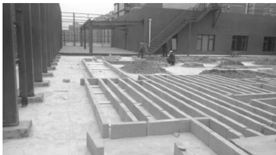
图9：混凝土梁做法
