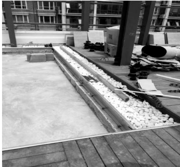
图 20: N形钢板封边结构做法照片
