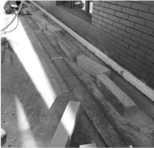
图 19: 石材道牙结构做法照片
