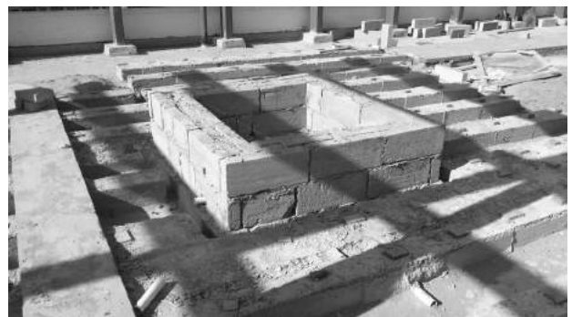
图 16：钢架结构树池座凳做法照片
