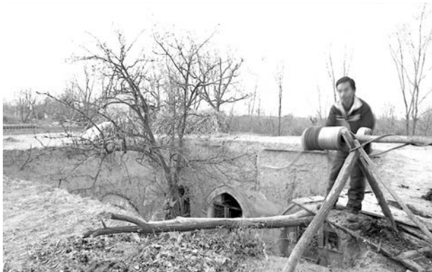
图4 建造中的地坑院（作者自摄）
