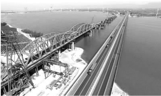
大桥跨越官厅水库施工期间水质无变化
