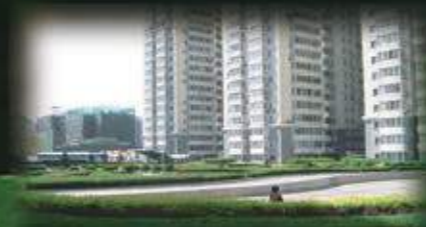
通惠家园一线国际平台防水层上高层楼群间的种植面（花坛、草坪）
