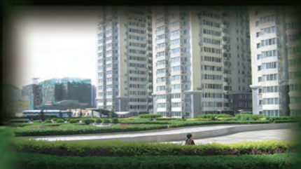
通惠家园一线国际平台防水层上高层 楼群间的种植面（花坛、草坪）
