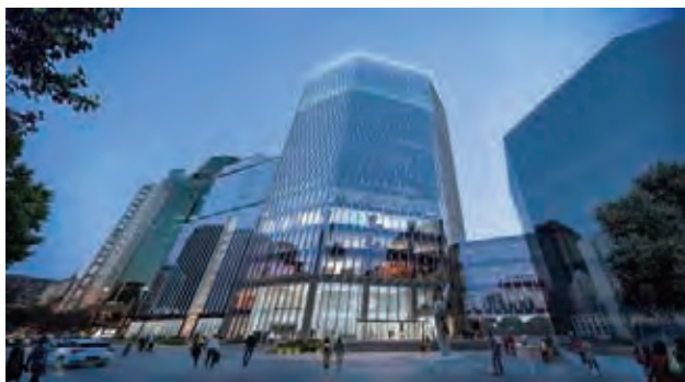
昆泰总部大厦重新定位
