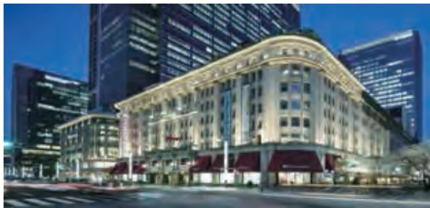
Nihonbashi 2-Chome Area Project - 日本东京
