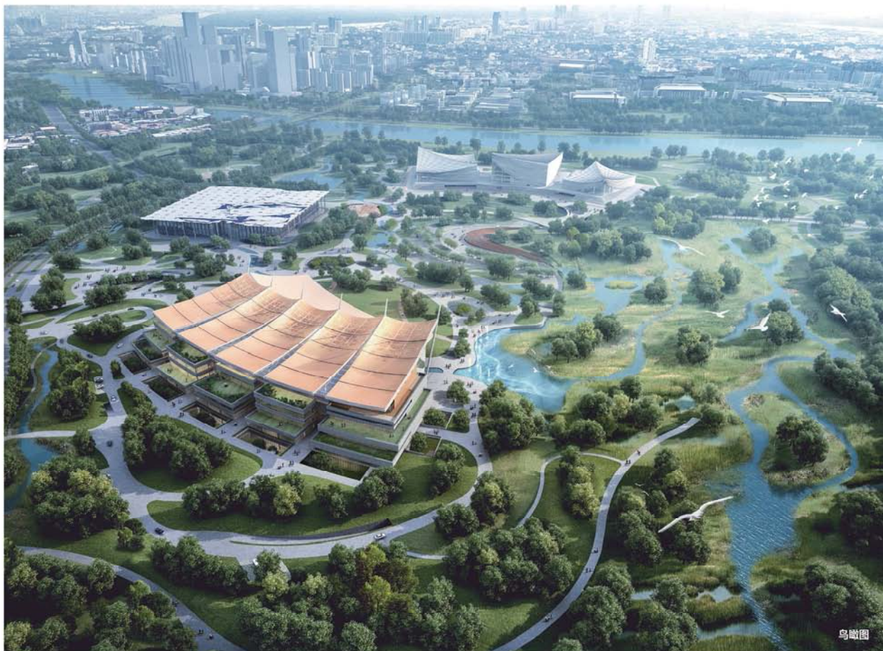
北京城市副中心文化建筑群
