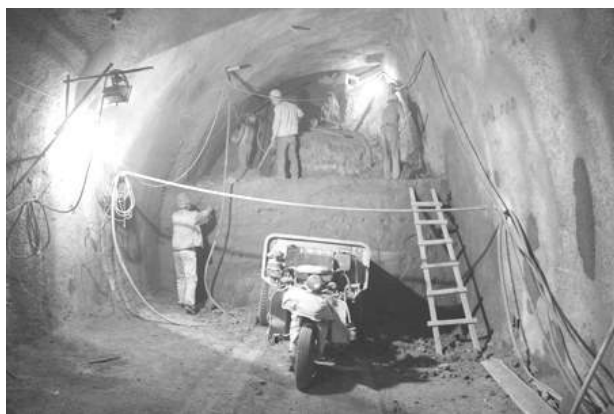
图5 某工程小导洞开挖施工实景
