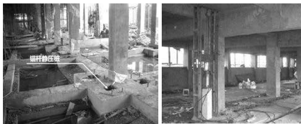
锚杆静压桩室内施工
