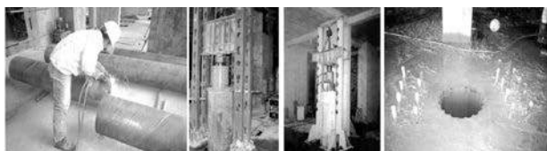
钢管切割 500吨级与300吨级静压装置 桩孔及其两侧预设锚杆
