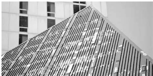
使用20年后剥落的涂层铝屋面
