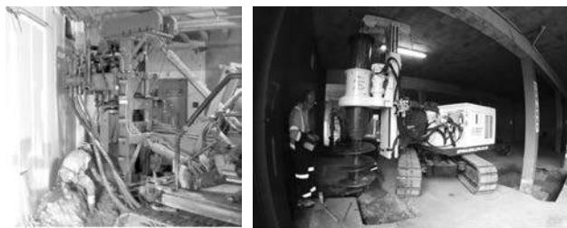
室内施工桩基托换示意
