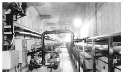
建于20世纪90年代，断面2m×2m 5m×5.3m，全长约5km。廊内管线：给水、再生水、空气管、污泥管、热力、电力管线等。
